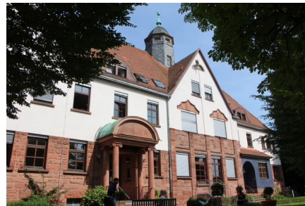
Schulstandort ehemaliges Landratsamt
